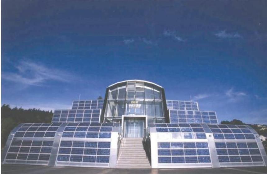
Fachada curva 22 Kw de Sistema Fotovoltaico, Instituto de Propaganda, Upper Austria, KW-Solartechnik, Áustria Integração da energia solar elétrica na arquitetura.
